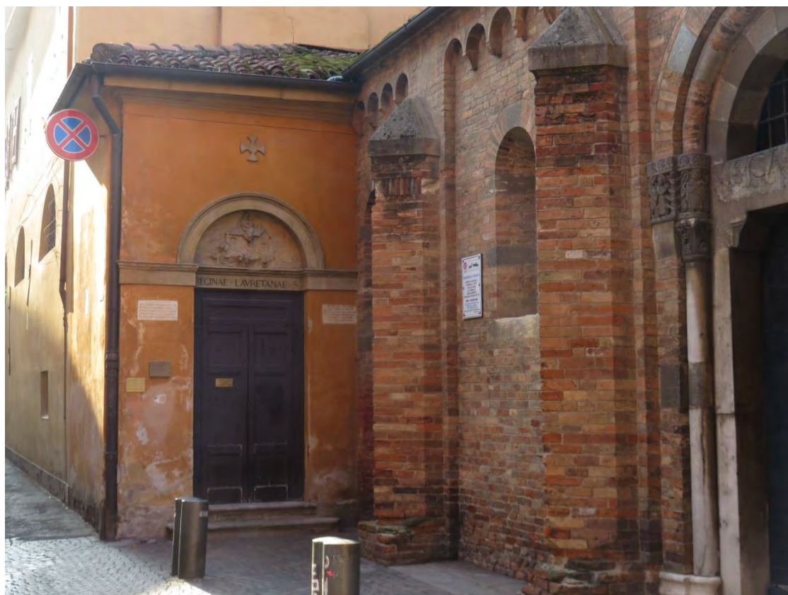
Foto n. 50: l'ingresso dalla Via Santa
